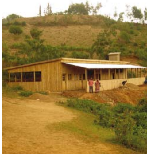
La ferme en construction à Nyamirambo.
